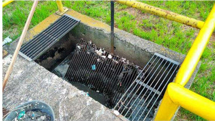
*Figura 140 - ETE Jardim Luiza - Grade após o tanque de aeração.*
