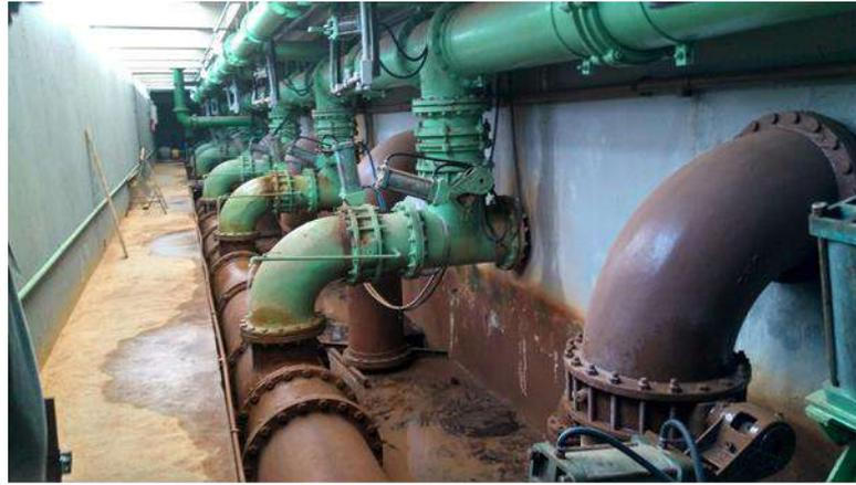
*Figura 52 - ETA - Sistema de Lavagem dos Filtros.*
