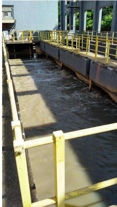
*Figura 117 - ETE Franca - Setor 1 - Caixa de areia em movimento espiral airada com canaleta de areia ao fundo.*
