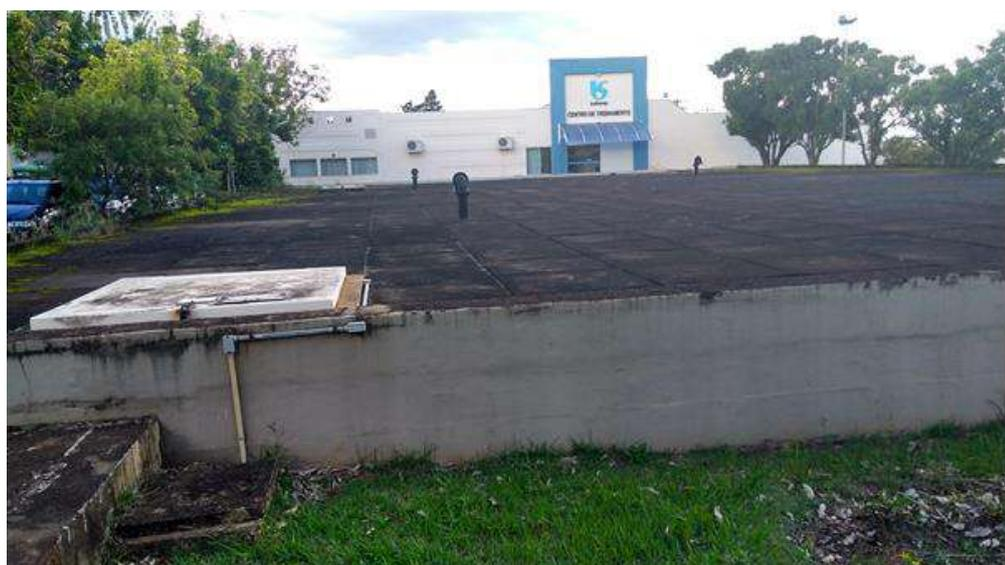
*Figura 55 - Reservatório Enterrado RN1.*
