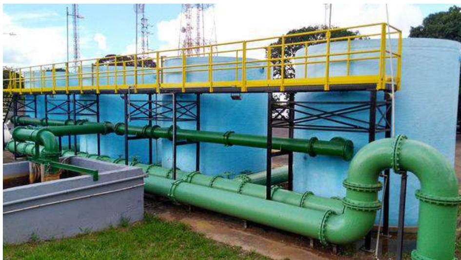
*Figura 51 - ETA - Filtros - 4 filtros em fibra de vidro.*
