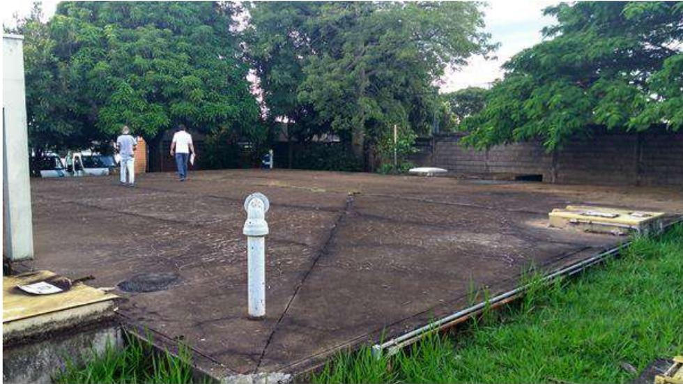
*Figura 57 - Sistema ETA (Setor I) - Reservatório Enterrado R0*
