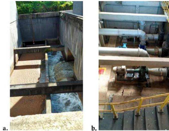
*Figura 119 - ETE Franca - Setor 1 - Poço de sucção após o tratamento preliminar e retorno do processo de tratamento (a) e EEEB – vista interna (b).*
