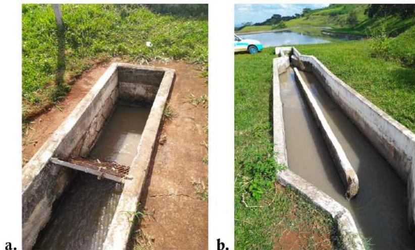
*Figura 150 - ETE Aeroporto - Chegada do esgoto, gradeamento (a), caixa de areia e calha Parshall (b).*
