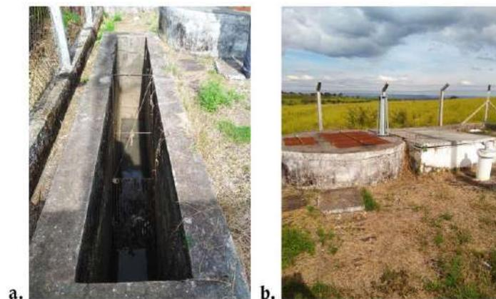
Figura 145 - EEE Aeroporto – Gradeamento, caixa de areia (a) poço de sucção (b).
