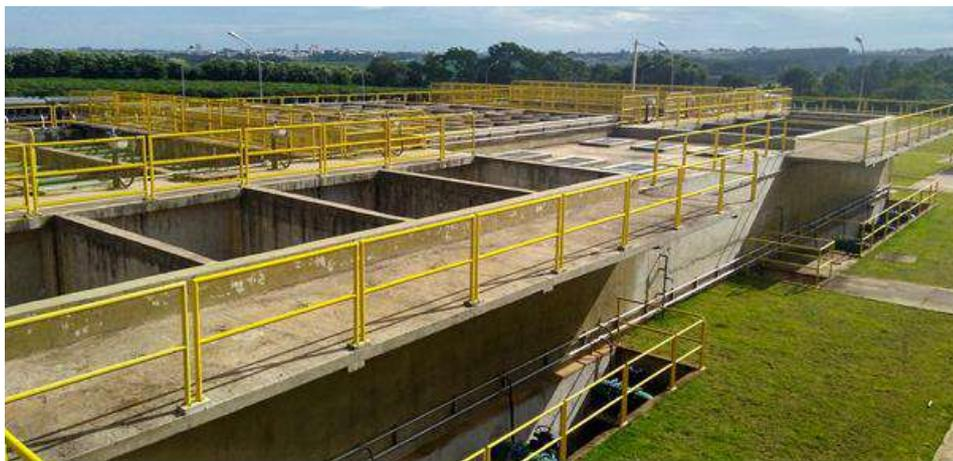
*Figura 104 - ETA - Vista geral de dois módulos de floculação, decantação e filtro.*
