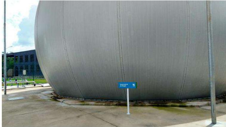
*Figura 128 - ETE Franca – Setor 6 - Sistema de Beneficiamento do Biogás - Reservatório de biogás.*
