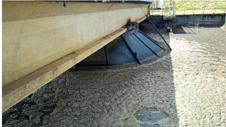
*Figura 122 - ETE Franca - Setor 3 - TAI - Aerador de superfície com campânula para retenção de aerosol.*
