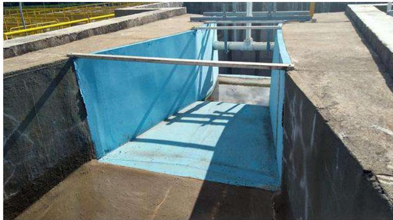
*Figura 103 - ETA - Calha parshall.*
