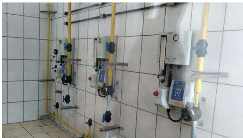
*Figura 101 - ETA - Sistema de dosagem eletrônica do gás cloro.*
