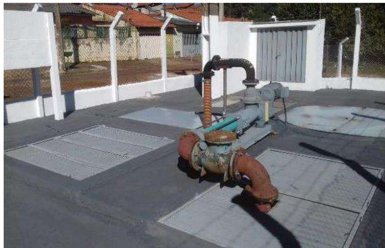
*Figura 113 - EEE Palmeiras – Poço de sucção e bomba.*
