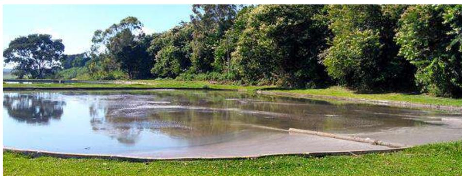
*Figura 165 - ETE Paulistano II - Detalhe da Lagoa Anaeróbica.*
