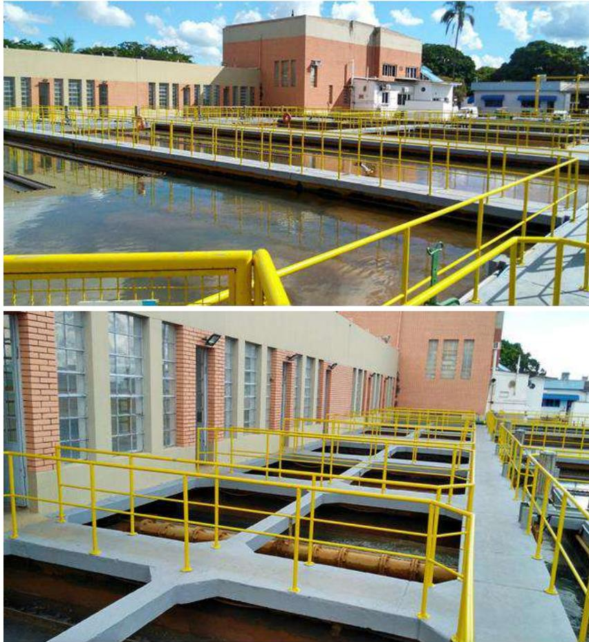
*Figura 50 - ETA - Decantadores e 7 Filtros em concreto.*
