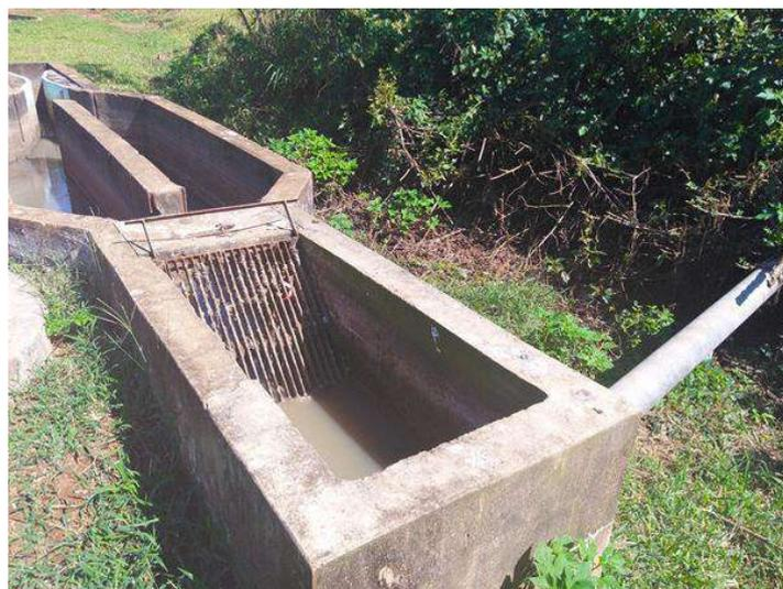
*Figura 161 - ETE São Francisco - Chegada do esgoto, gradeamento, caixa de areia e calha Parshall.*
