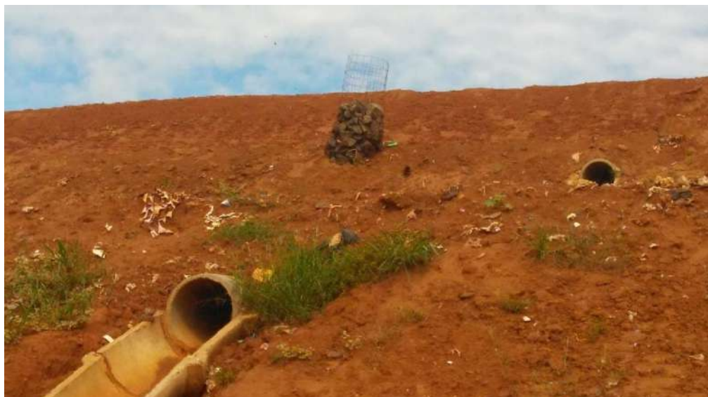
Figura 186 – Drenos de gás e Canaletas no Aterro municipal.
