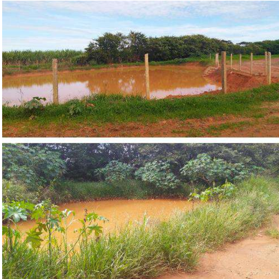
Figura 185 – Dispositivos de drenagem no Aterro municipal – Bacias de retenção.
