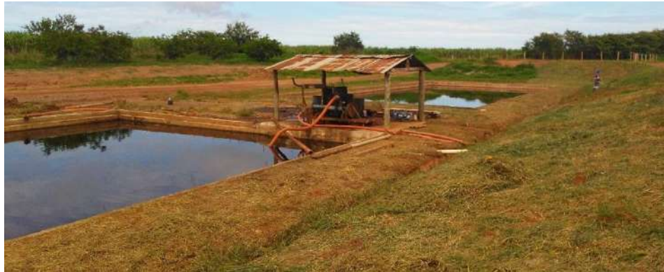
Figura 187 – Lagoas de Chorume no Aterro municipal.
