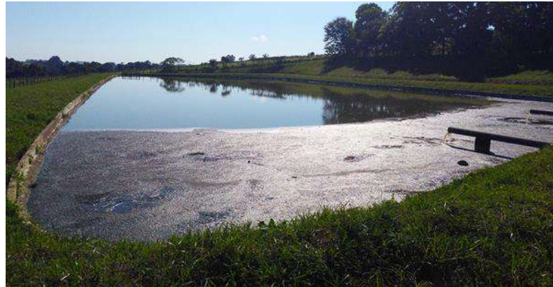
Figura 170 - ETE City Petrópolis - Lagoa facultativa.
