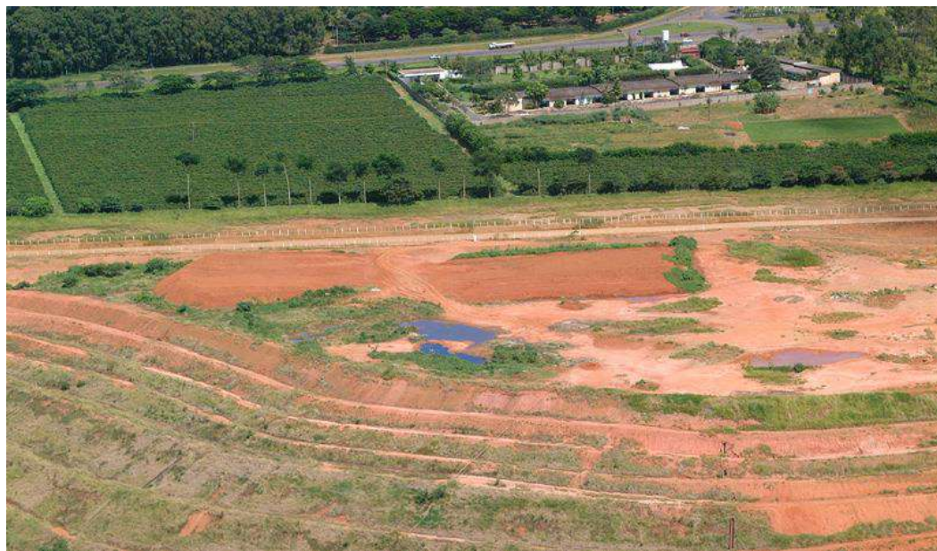
Figura 192 – Vista geral – Aterro da Fazenda Municipal.
