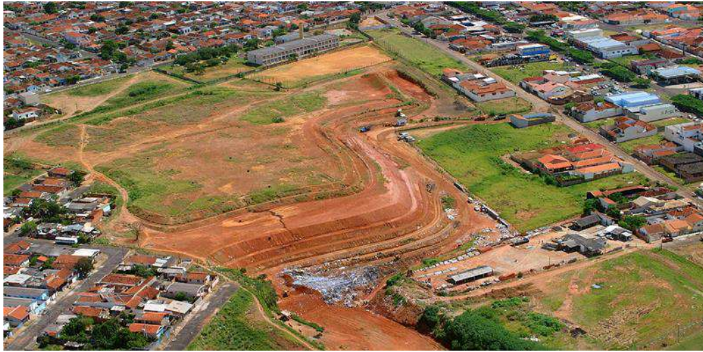
Figura 191 – Vista geral – Aterro das Maritacas.
