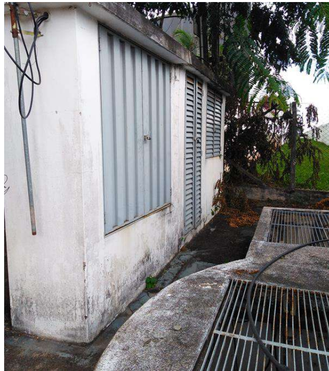
Figura 171 - EEE Morada do Verde - Poço de sucção com cesto de gradeamento e Quadro elétrico.
