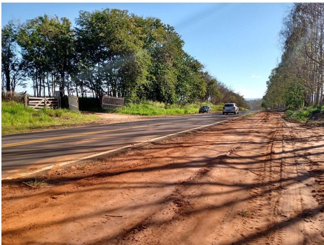
Nivelamento do acesso e pavimentação da via oposta para a construção de um trevo seguro
