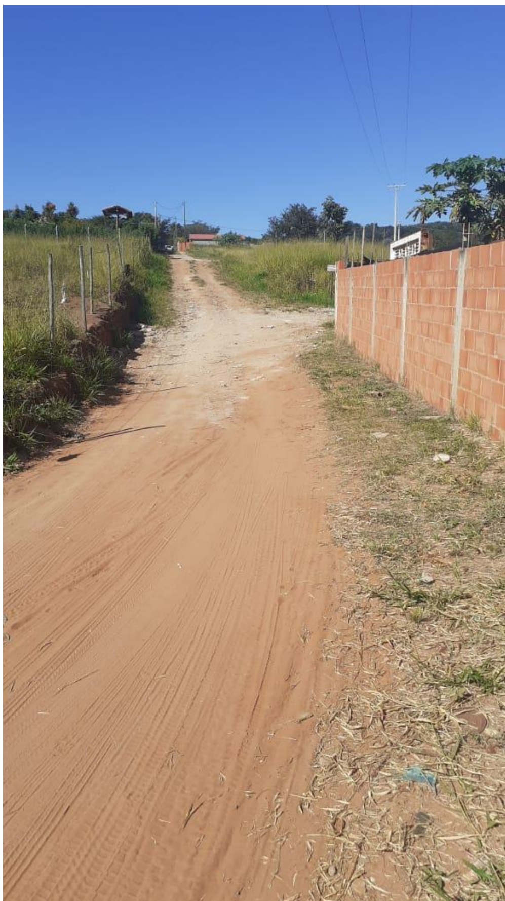
Colocação de cascalho em toda a extensão da estrada acima
