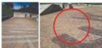
Lapidação do piso
