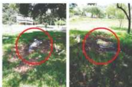
Verificar a caixa de passagem da água que drena da mina
