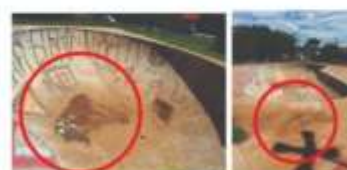
Fazer a canaleta de contenção de água evitando do barro cair dentro do banks
